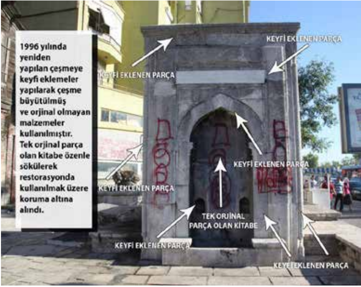
1996 yılında Kadıköy ve Havalisi Camii Yapma, Onarma Derneği tarafından çeşme aslına uygun olmayan şekilde yeniden yapıldı.
